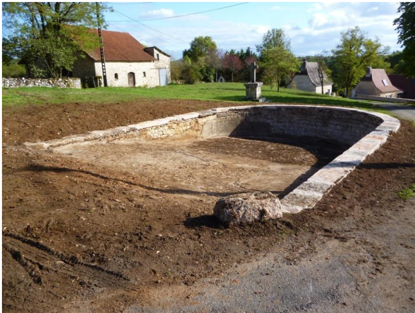
Fin des travaux
