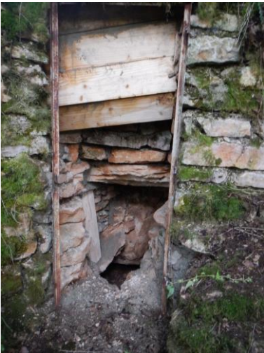
La sécurisation de l'accès artificiel au réseau des pertes et installation de broches inox.
