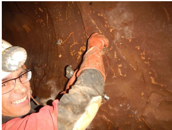
La sécurisation de l'accès artificiel au réseau des pertes et installation de broches inox.
